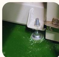
地震による アジャスターボルトのずれ
